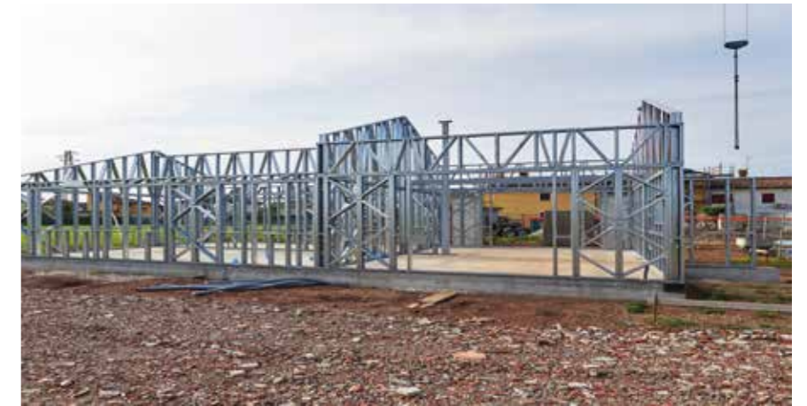
Fotos del sitio y montaje
