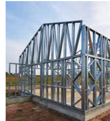
Fotos de la construcción
