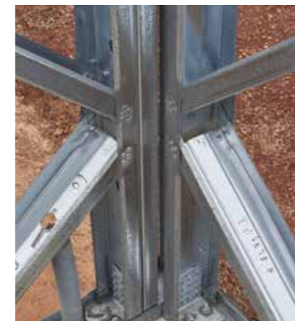
Fotos del sitio de construcción y esquina de enganche de paredes (detalle3)
