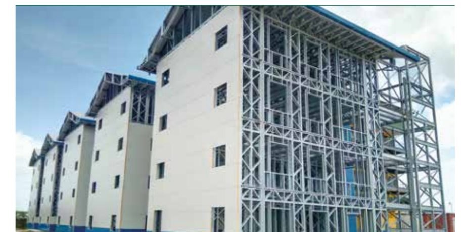
Foto del sitio de construcción con panel sándwich adjunto Sección estructural
