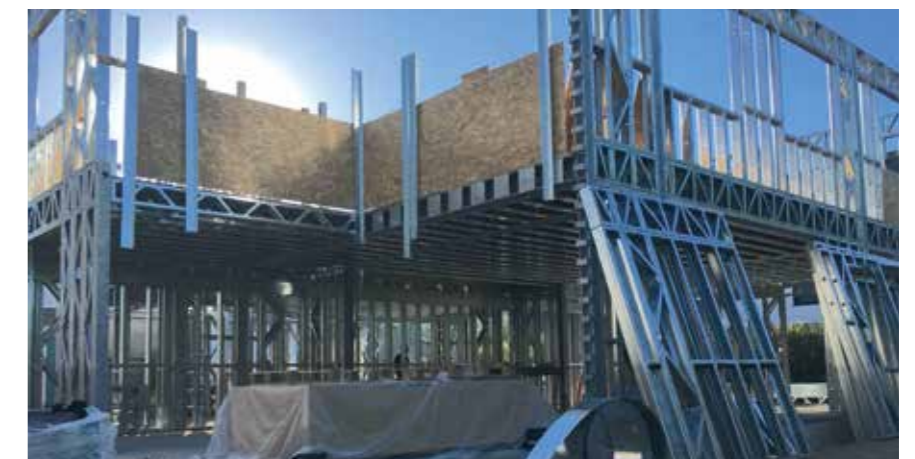
Foto del montaje del sitio de construcción
