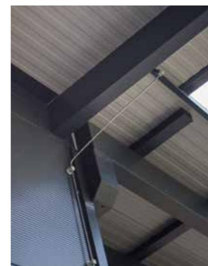
Foto de detalle de la cobertura con la estructura de acero y los paneles ISOCOP.
