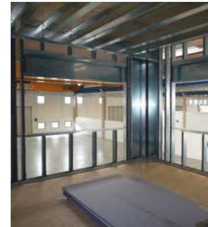
Foto de la fase de construcción del interior
