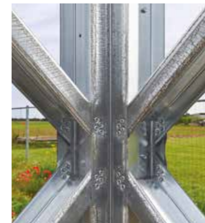
Fotos de detalle y arriostamiento de llaves
