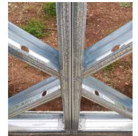
Detalle del acoplamiento a tierra del sistema Manni Green Tech
