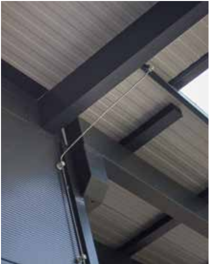
Foto di dettaglio della copertura con il focus sulle strutture in acciaio e i pannelli ISOCOP.
