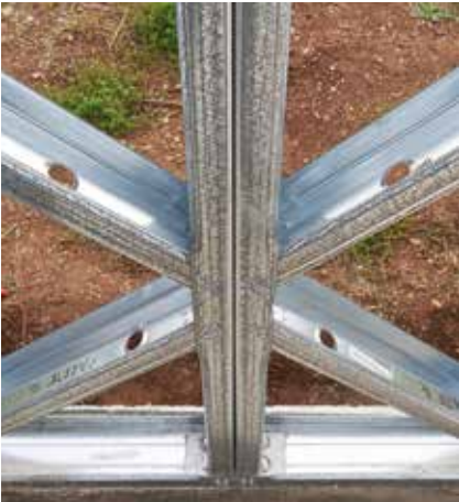
Dettaglio dell'attacco a terra del sistema Manni Green Tech
