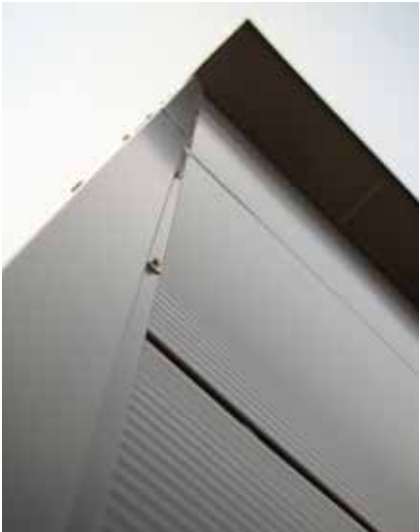
Foto di dettaglio del pannello e lattineria di finitura.
