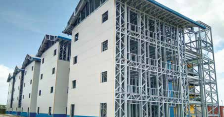
Foto di cantiere con fissaggio dei pannelli Sandwich
