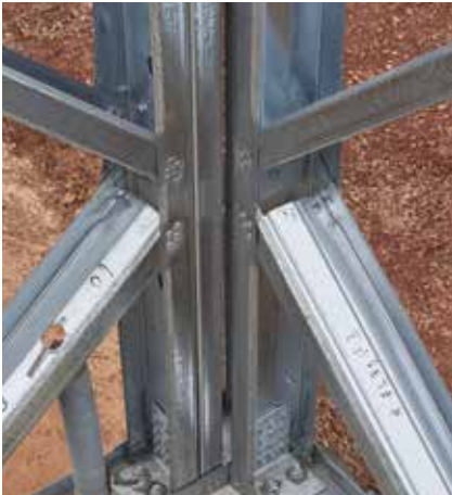
Foto di cantiere del fissaggio ad angolo delle pareti (dettaglio 3)
