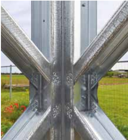
Foto di dettaglio del sistema di connessione dei controventi ai profili verticali
